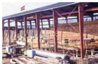
Renovering af Fregatten Jylland. Privatfoto.
