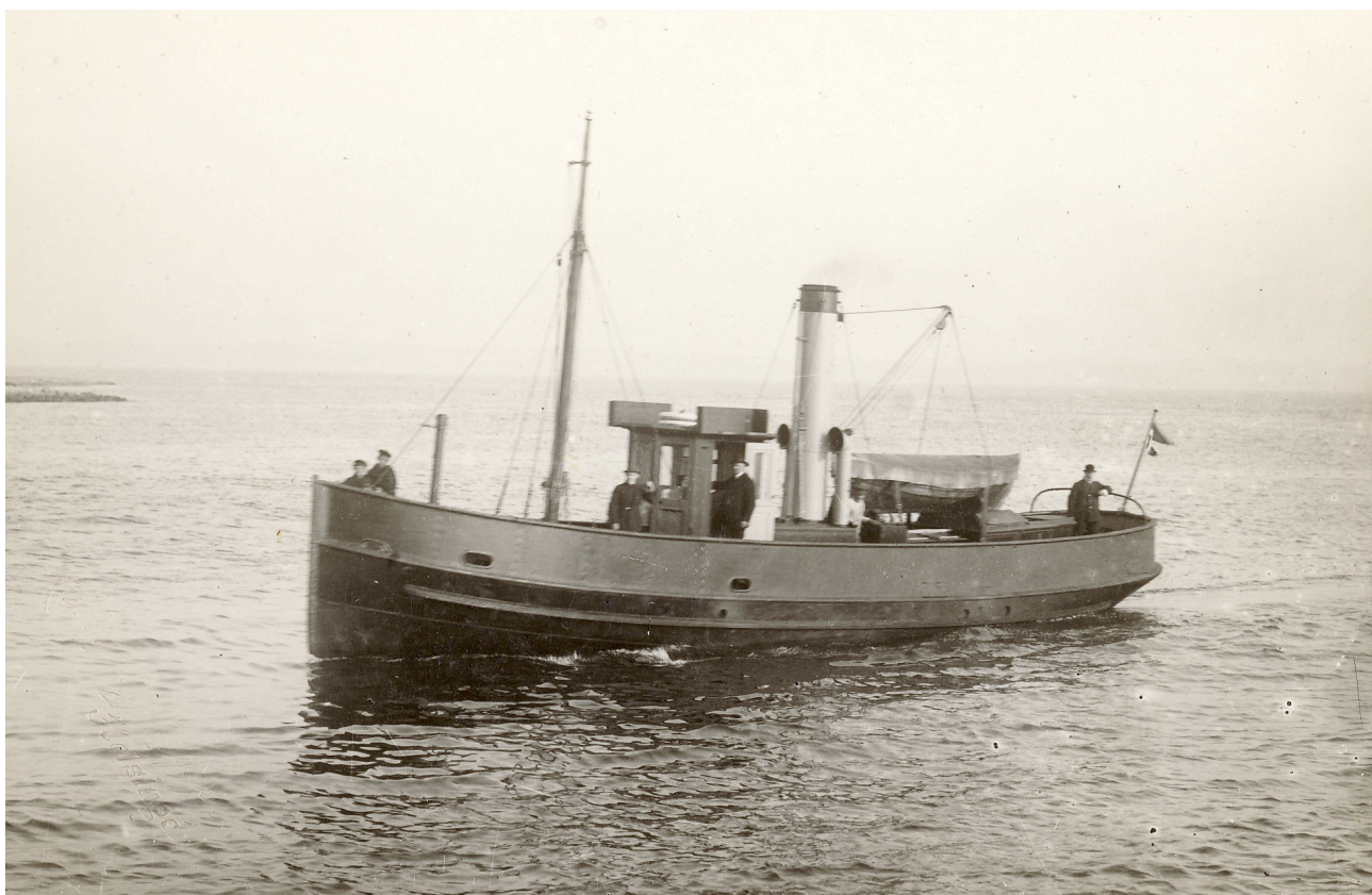
Fotoet viser lods båden Helsingør, der blev bygget på Helsingør Skibsværft og var 10 meter lang og 3,60 meter bred. Foto: Museet for Søfart.
